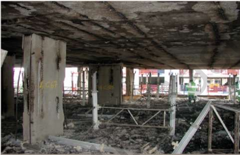
სურათი 4.10. ხანძრის ინტერიერის ხედმა დააზიანა ბეტონის კონსტრუქცია.
